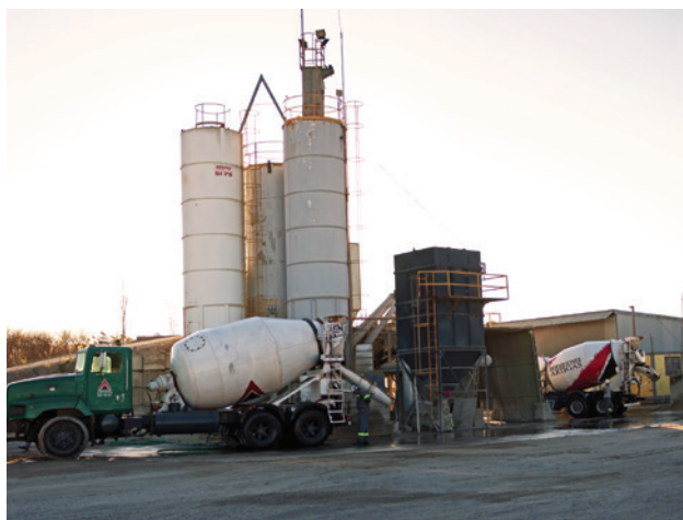
Fig. N°6 Planta de hormigón premezclado en Departamento de Maldonado.
