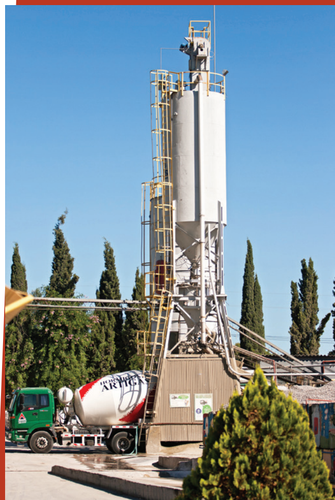
Fig. N°5 Planta Oncativo, hormigón premezclado Departamento de Montevideo.
